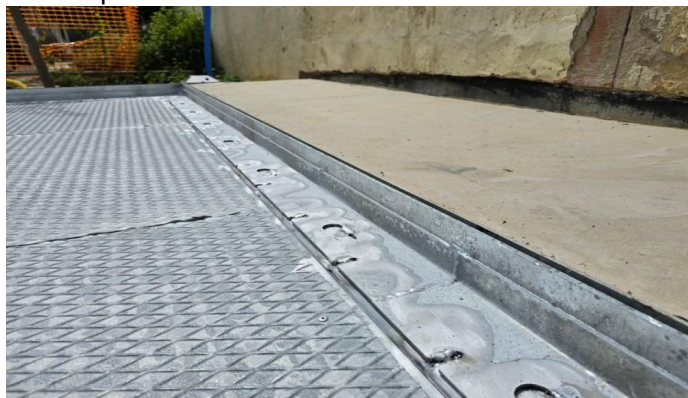
Vasca pavimentazione 85 mm
