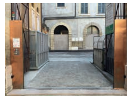
Rivestimento in rame e plexiglass
